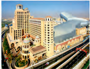
Mall of Emirates Dubai / U.A.E
